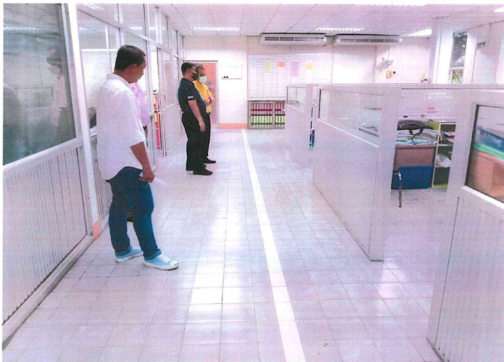
อาคารส่วนก่อสร้าง อำเภอเมือง จังหวัดพิษณุโลก ที่ดินแปลงที่ 3 ถนนราเมศวร สำนักงานทางหลวงที่ 5
