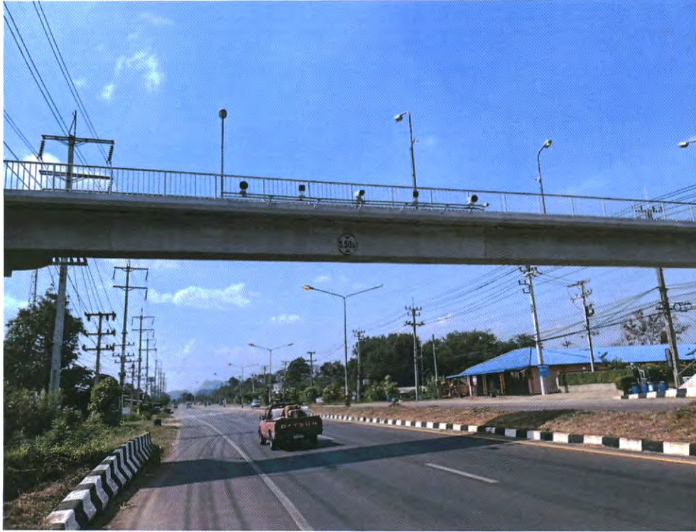
ภาพแสดงตัวอย่างการติดตั้งระบบควบคุมการใช้ความเร็วบนทางหลวง
