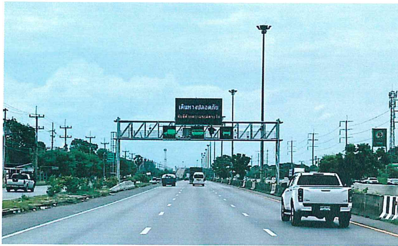
รูปที่ ๒.๑ แสดงตัวอย่างระบบบริหารจัดการการใช้ช่องจราจรบนทางหลวง
