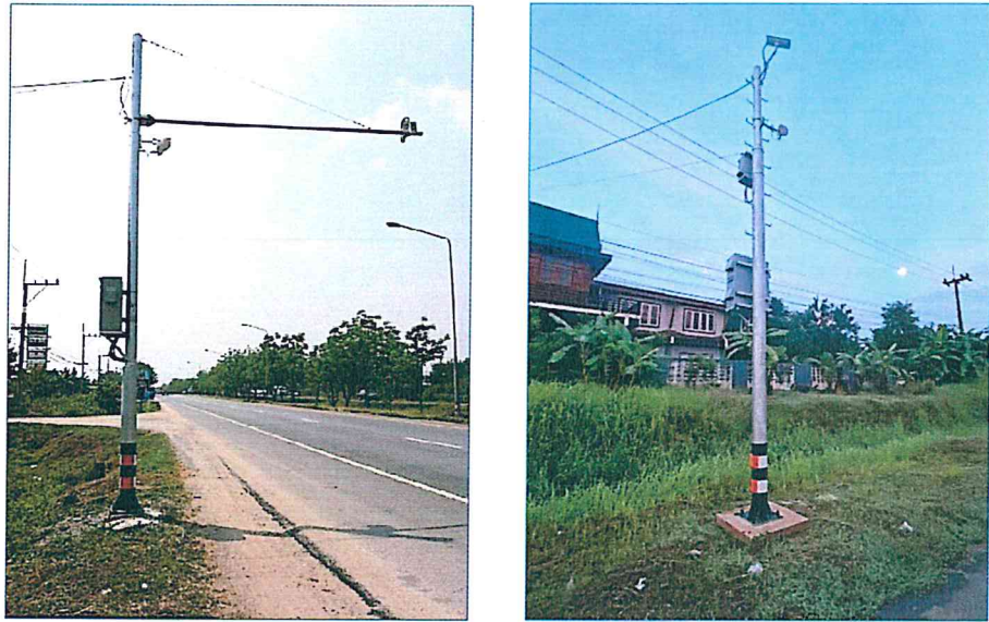
รูปที่ ๒.๑ แสดงตัวอย่างเครื่องสำรวจปริมาณจราจร ที่ติดตั้งบนทางหลวง
