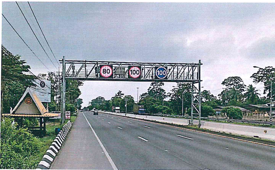
รูปที่ ๔.๑ แสดงตัวอย่างระบบควบคุมการใช้ความเร็วจำกัดแต่ละช่องจราจร
