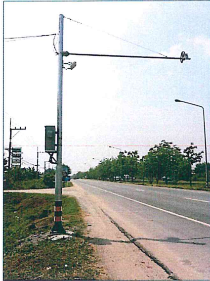
รูปที่ ๖.๑ แสดงตัวอย่างเครื่องสำรวจปริมาณจราจร ที่ติดตั้งบนทางหลวง
