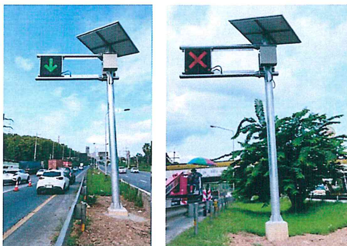
รูปที่ ๕.๑ แสดงระบบแจ้งเตือนการเปลี่ยนทิศทางการเดินทางสำหรับการ เปิด - ปิด ช่องทางพิเศษ
